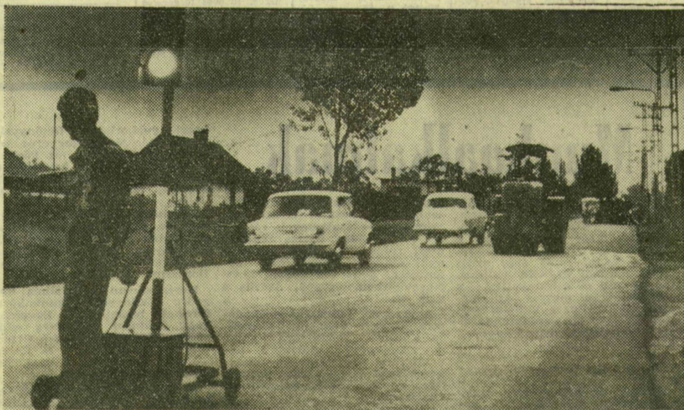
Somogyi Károlyné felvétele Korábbi ígéretéhez híven, még az ünnepi hetek kezdete előtt befejezi az Aszfaltút-építő Vállalat a Fonógyári út szélesítését. A nyolcméteres út aszfaltburkolatát éjszaka terítik szét, hogy a forgalmat lehetőleg ne zavarják.
