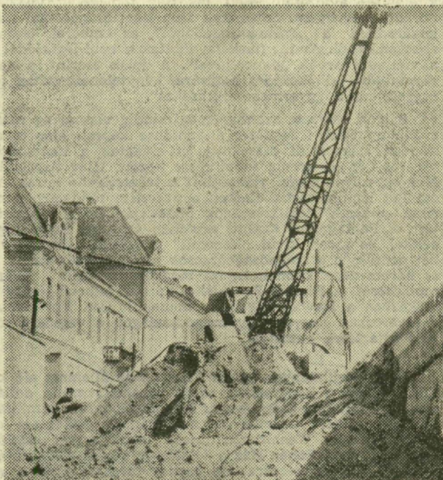
A régi és az új támfal között mintegy 9 ezer köbméter föld kitermelésével készítik helyet a lépcsőknek.
