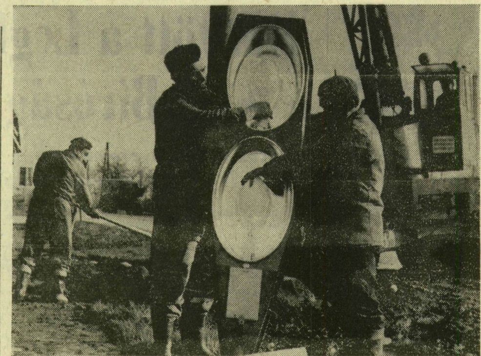
AZ E5-ÖS ÚTON, az Izabella-híd és a gumigyár közti szakasz mindkét oldalán új lámpaoszlopokról, világítótészténként két-két darab 1000 wattos higanygőzös szórja majd a fényt. Képünkön: a DEMÁSZ munkásai az utolsó oszlopokra szerelik a világítást.
