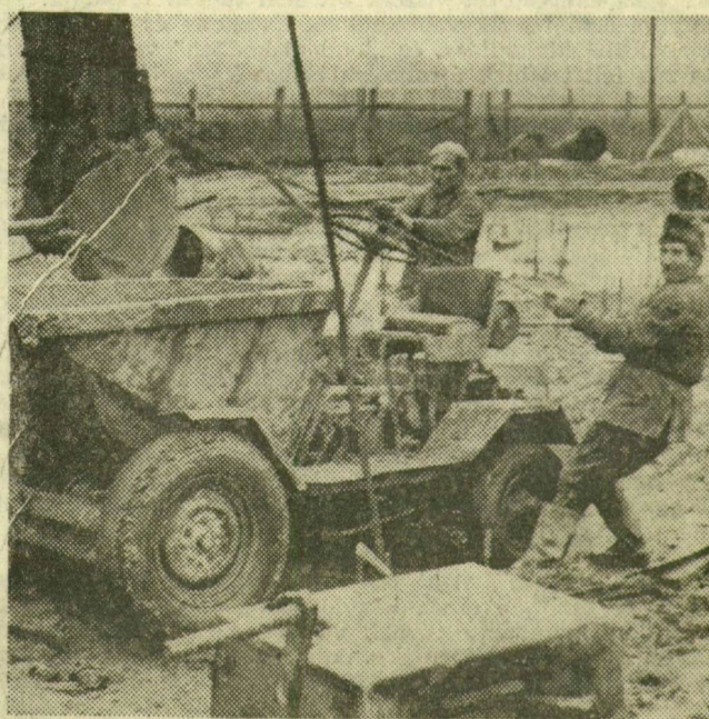
Nehéz körülmények között dolgoznak az építők a sok esőtől alaposan fölázott talajon.
