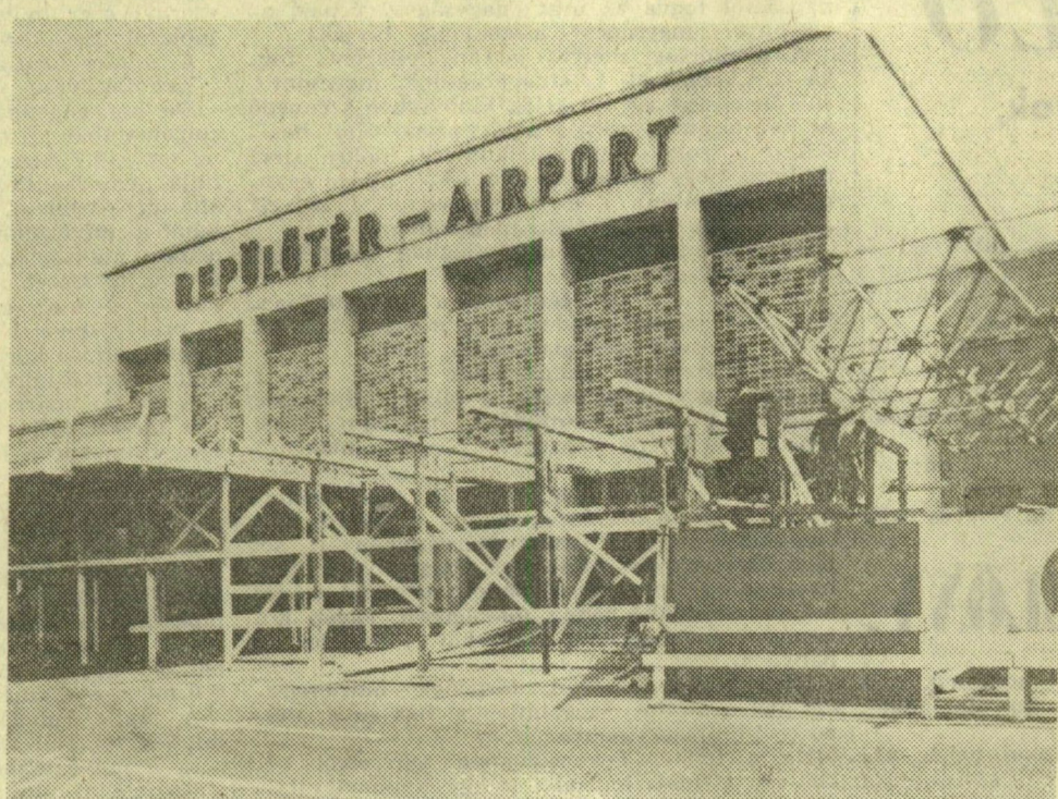
A Ferihegyi repülőtér rekonstrukciója során új utasforgalmi csarnokot készítenek, könnyűszerkezetes építési módszerrel. Korszerűsítik a jegy-, ütélevél- és vámkezelő helyiségeket is. A hűtött forgalmi épület évente kettő és fél millió utast tud fogadni.
