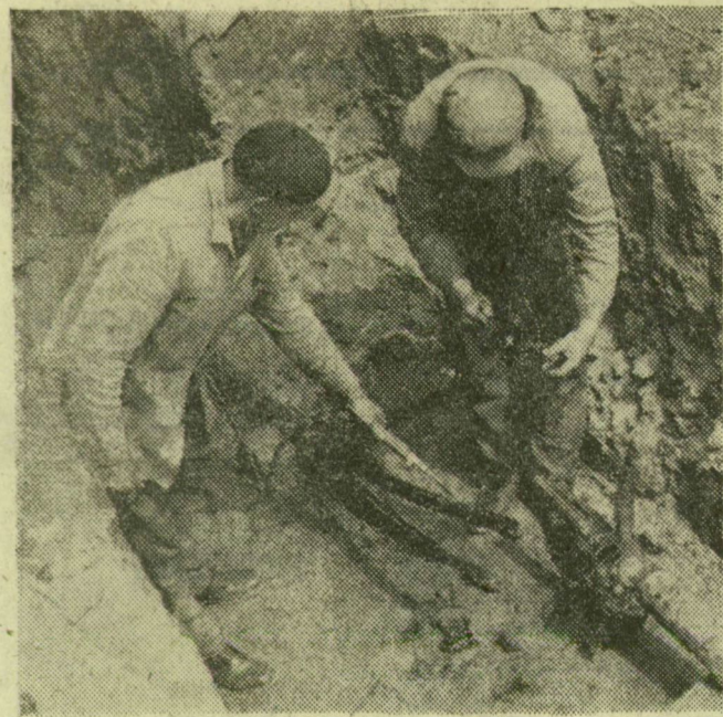
Tisztítják a föld alatti kábelvéget
