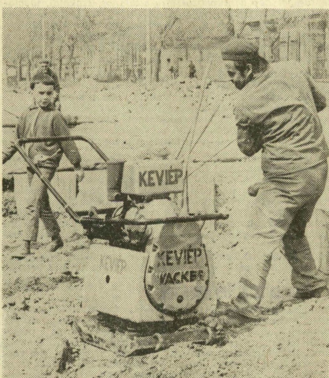
Az elkészült részen tömörítik a betöltött földet
