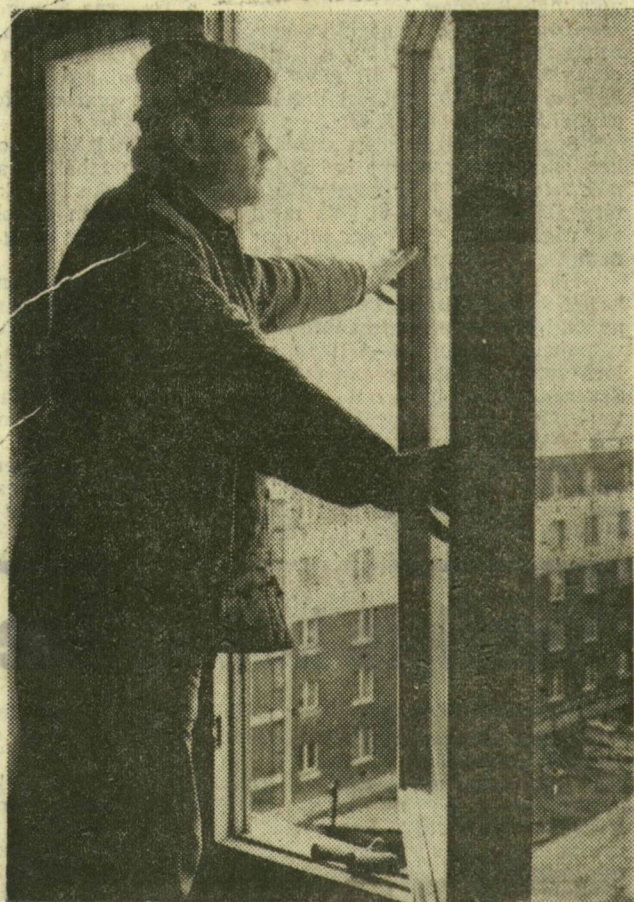
Az asztalosok beillesztik az ablakot a helyére, hogy jól zárjon és „passzoljon”.
