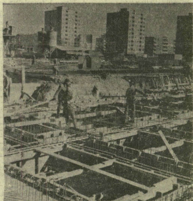
Ha földbe került a vasbeton cölöp, megkezdik a fogadósínt építését
