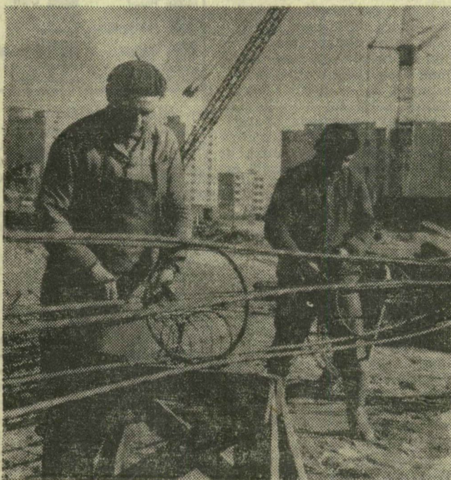
A speciális cölöpök henger alakú vasvázát készítik
