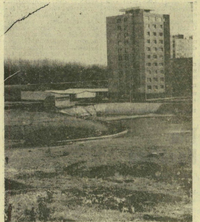
A nád kivágása után Létfőn már megkezdődhet a földmunka
