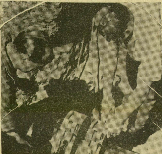
Hegesztés előtt szorítóbilincset szerelnek a csövek végére
