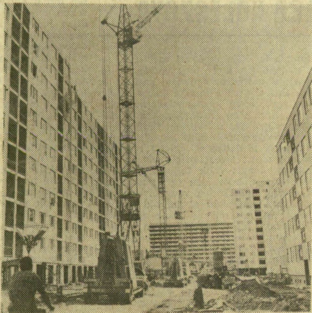
Somogyi Károlyné felvétele Tízemeletes-szalagházat szerelik a József Attila sugárút mentén, háttérben a monolit elemekből készülő 101-es jelű tízenkét szintes lakóépület.
