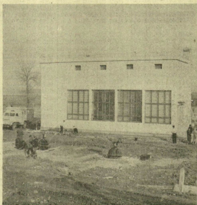
Az Alsótiszavidéki Vízügyi Igazgatóság 1972-ben is számos vízügyi építkezést befejezett. Jelentős volt a munkák között a nagyfai új szivattyútelep megépítése. A régi, gőzüzemi szivattyút elektrifikálták, és teljesítményét megkétszerezték. Képeinken: az új szivattyútelep épülete és hullámtéri csatornája.
