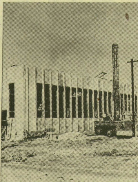
A szerelőcsarnok egyik sokablakos oldalfalát örökítették meg a képen. Belülről szakipari műhelyek, raktárak és a tmk-műhely kap helyet.
