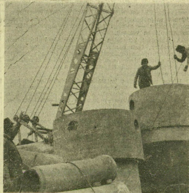
Magasban és mélyben: az aknamélyítő vállalat munkái betonoszák az iparkörzeti szennyvíz- és csapadékatemelőt
