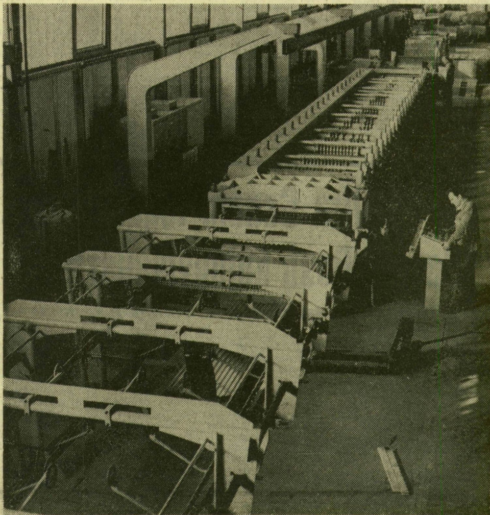
A Magyar Alumíniumipari Tröszt új gyártócsarnokában francia hullámosító gépsor dolgozik
