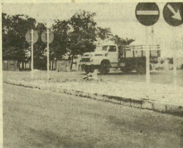
Minden autózvezető nagy öröme az E 5-ös út építése elérte már a Szatymazi bekötő utat. A kereszteződésben korszerű forgalmi csomópontot alakítottak ki.
