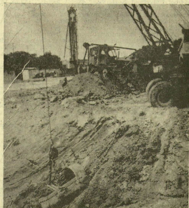
A földmunkák zömét gépekkel végzik. Az egyik pillér alapjait vájja a markoló
