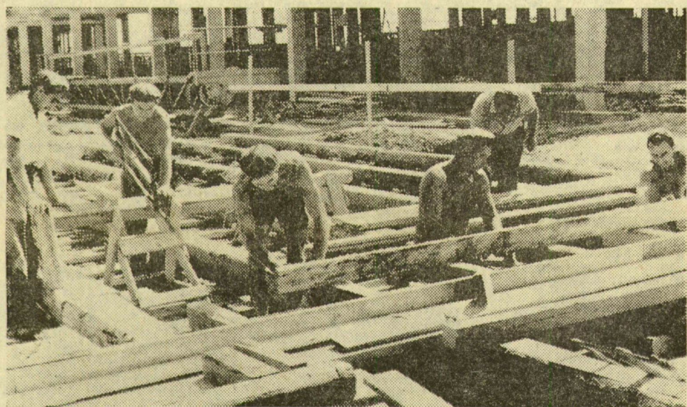
Az ácsok „kiköltöztek” a csarnokból, most már a házgyár melletti kiszolgálóépület betonformáit készítik
