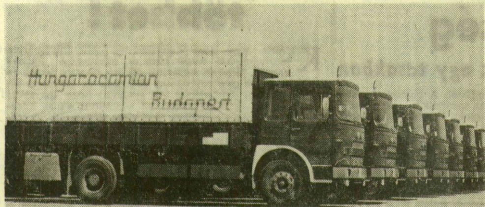
A győri Magyar Vagon- és Gepgyár 160 kamiont gyárt ebben az évben. A 38 tonna súlyú, 215 lóerős Rába-Mann motorral működő, 18 méter hosszú járművekből az első tíz már el is készült a Hungarocamion Vállalat rendelésére
