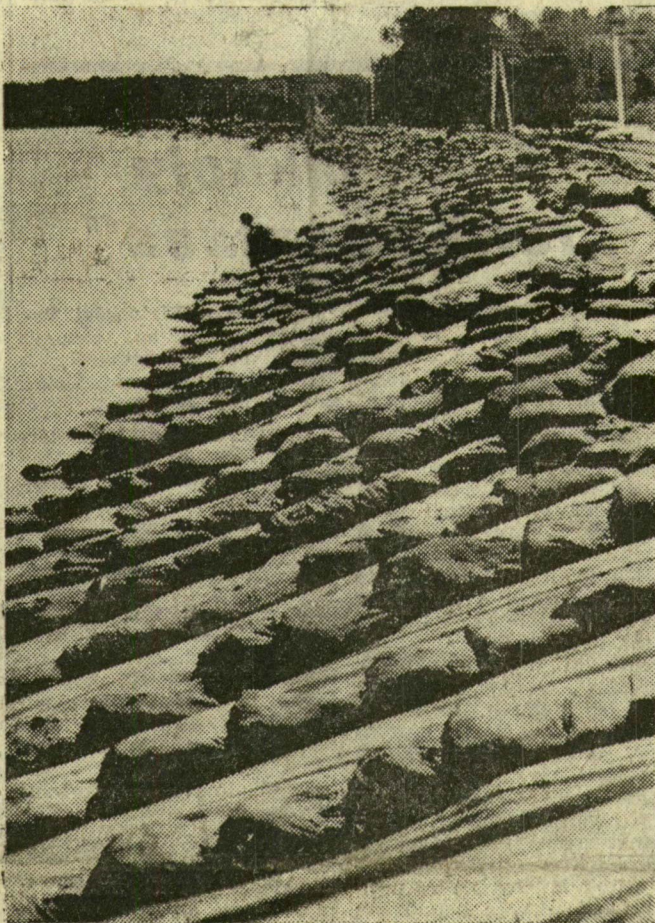
A rövid ideig tartó apadás idején megmutatkozott, milyen precíz munkát végeztek a fóliázásnál a bűvárok
