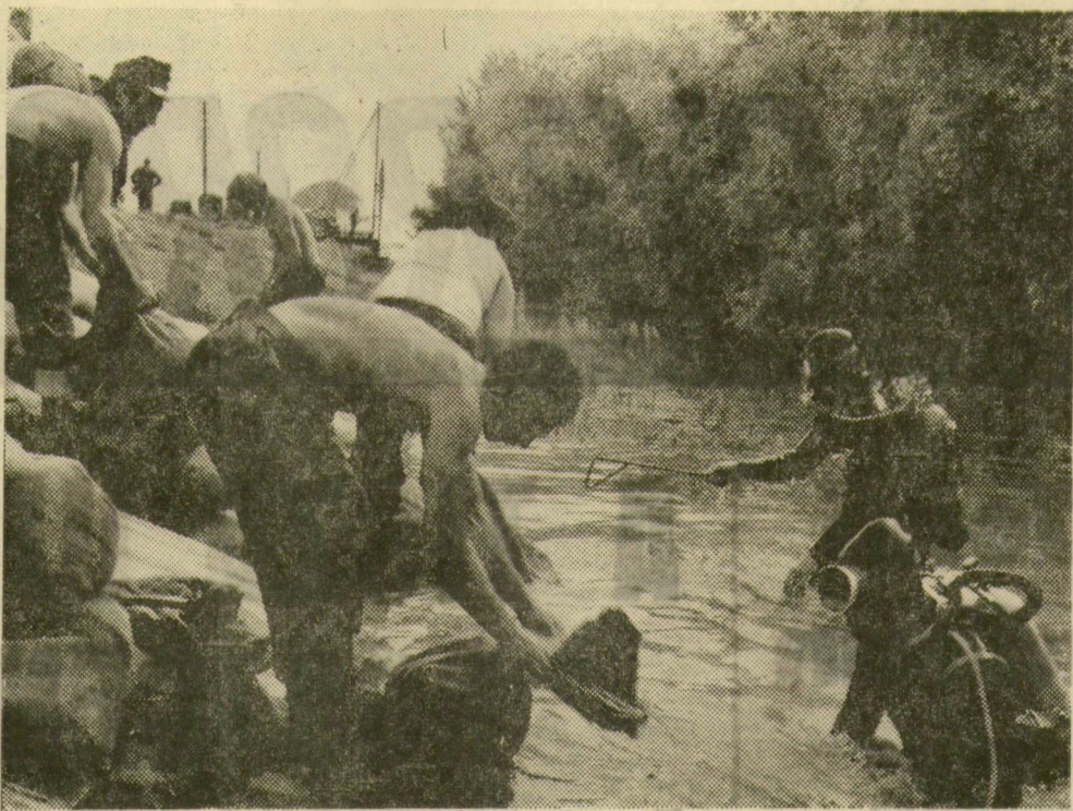
Az újszegedi oldalon könnyűbúvárok föllett és homokzsákokat helyeznek el a víz alatt
