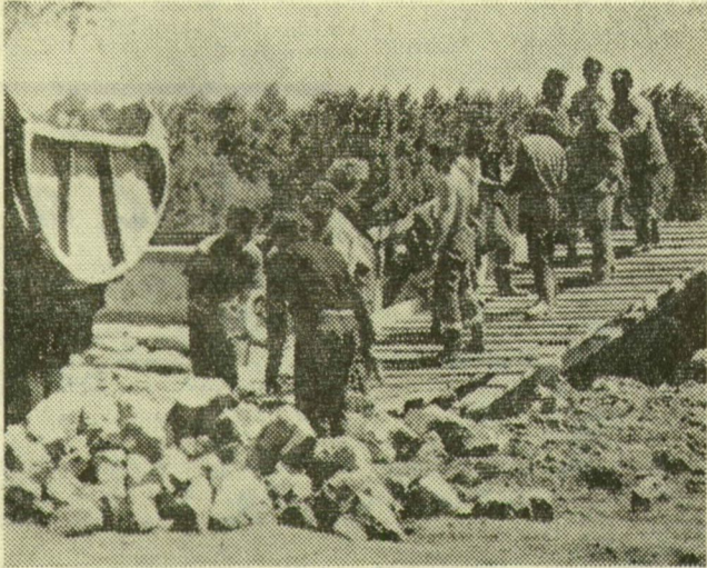
Köre is szükség van a töltések erősítéséhez. Képünkön: munkalánc továbbítja a követ a horgonyzó uszályba
