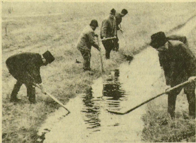
Szatymazon, a Homokgyöngye Tsz földjein is szűnültig tel-tek a levezetőcsatornák. Farkas Dezső brigádja ásóval, ka-pával segíti a víz gyorsabb továbbjutását, hogy minél kevesebb kárt tegyen
