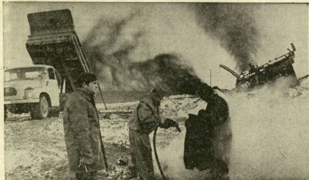
A vattakabátba rakódott olajréteget gőzzel távolítják el
