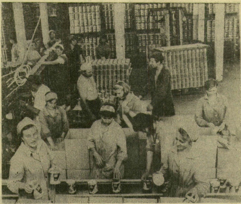
Somogyi Károlyné felvétele CIMKÉZES GÉPPEL. A Szegei Gépgyár szervizos nagy raktárában gép váltotta fel a címkégyártó asszonyokat. A géppel óránként 3-8 ezer doboz címkézést végezhetik el
