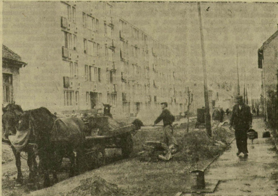
Locsolják az új járda betonját
