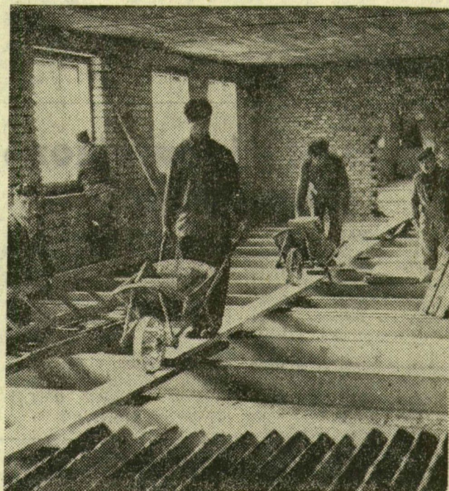
A Lenin körút 21. számú emeletráépítés „tető alatt” van, a lakások válaszfalai készülnek
