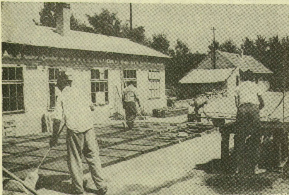
A formázóasztalról sorra a szárítótérre kerülnek a járdalapok, s pár nap múltán készek a szállításra. Az elfuvarozást is a tsz bonyolítja le
