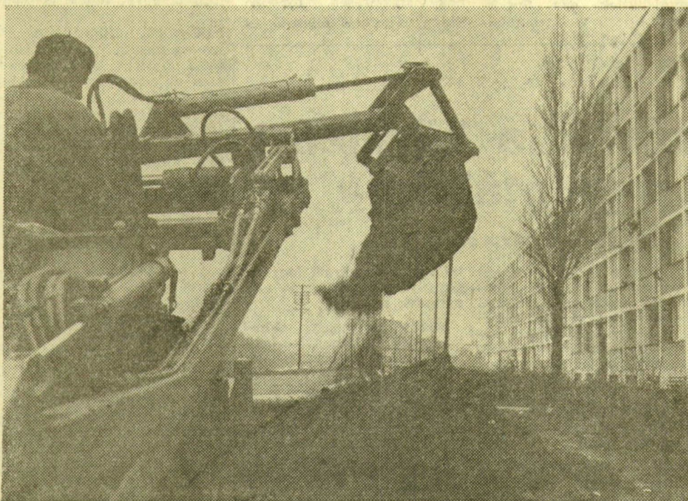
Újszegeden, az Alsókőrösi soron dolgozik az árokásó gép, hogy elhelyezhessék az új gázvezeték. Ez a munka is része annak, hogy Újszeged tiszta földgázt használhasson
