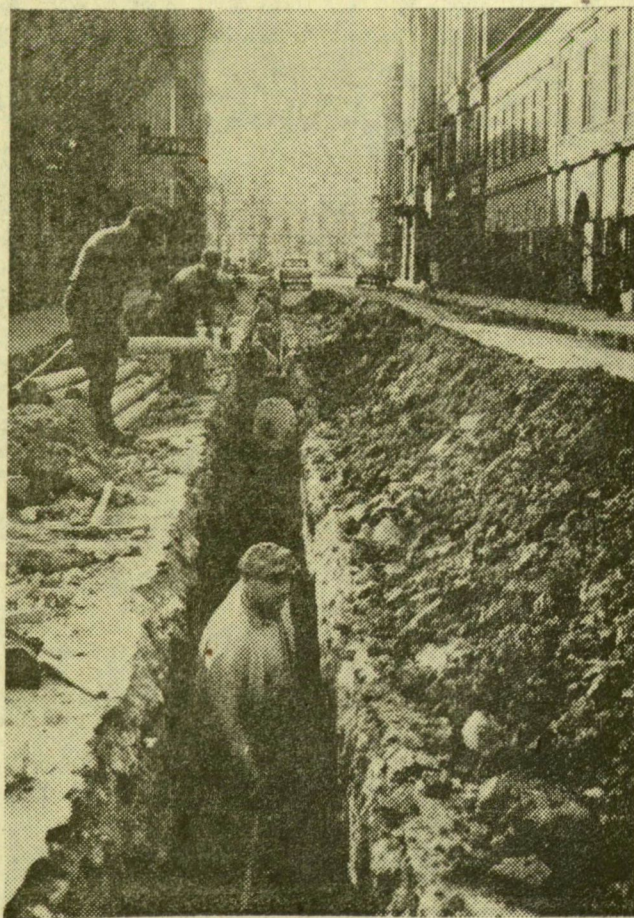
Munka a Horváth Mihály utcában. A vízművek szakmunkásai új, nagyobb átmérőjű nyomócsövet helyeznek el a régi, szűk keresztmetszetű és avult helyett.
