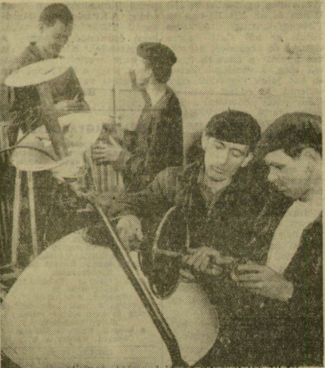
Fábi Dezső villanszerelő brigádja a sebészeti klinika építkezésén
