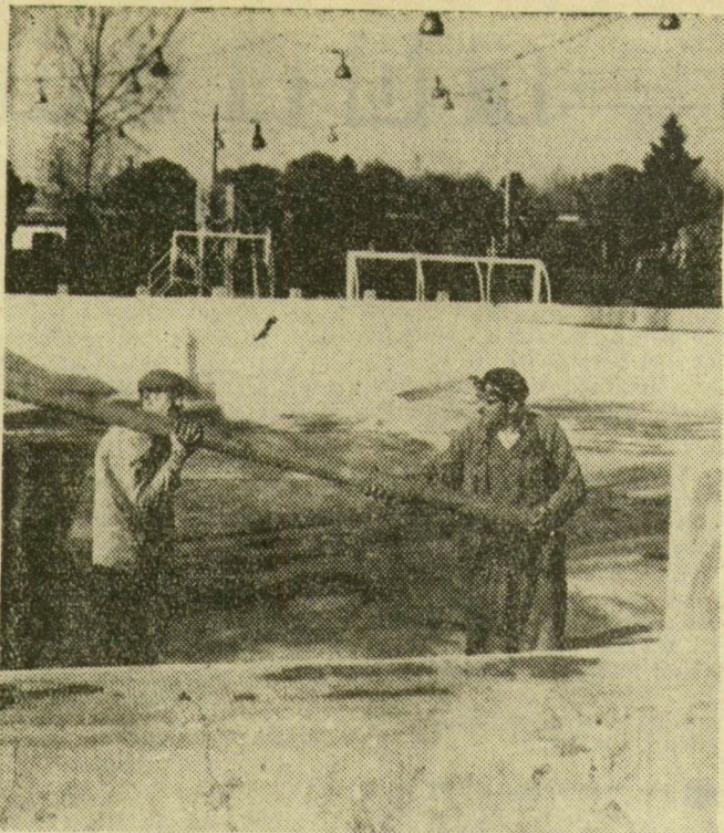
A meleg víz vezetéséhez fektetik le a csöveket a medencébe
