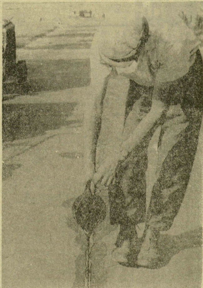
A Közüti Igazgatóság már a télre készíti az 5-ös számú főközlekedési utat Szeged határában. Hézagöntők járnak az út különböző szakaszait, hogy forró bitumen-öntéssel tömítsék a hézagokat
