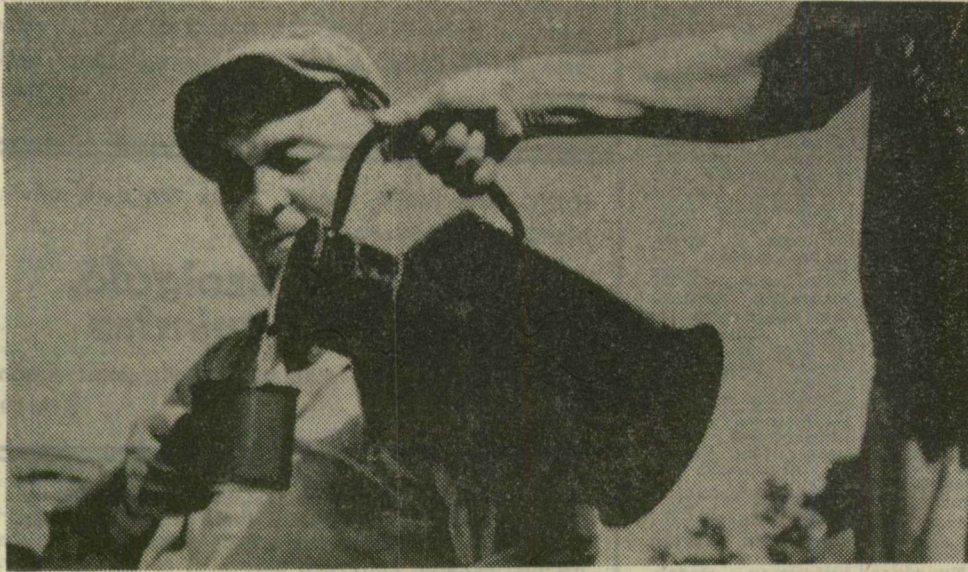
Jólesik a hideg víz munka közben az épülő lakóház tetején, az Oskola utcában
