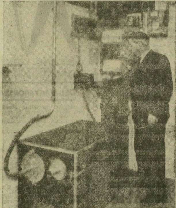
A pincében elhelyezett központi porszívó, amely már nemigen hasonlít a lakásban használatos válfajához. Beépített villamos berendezése maximális üzembiztonságot nyújt.
