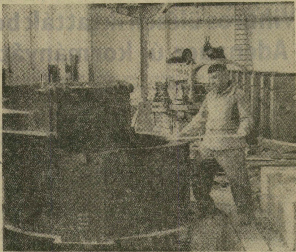
Szerelik a Szegedi Kábelgyár dróthúzó üzemének újabb gépegységét. A képen látható kemence felszerelése után a géppark munkára készen áll. Most már az építő vállalat munkájától függ, mikor kezdheti meg a termelést a gyár új üzemrészé.
