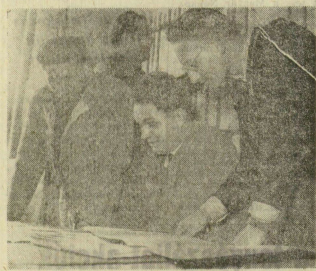
Tanácskozik a „vezérkar”. Szolcsányi Gábor építésvezető csaknem naponta hívja megbeszélésre Tolnai Tibor technikust, Helbert Mihály művezetőt és Lehotai Ferenc anélget. Az építés közben adódó problémákat közösen oldják meg.
