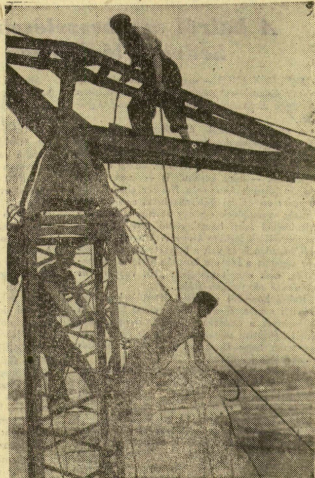
Szerelik a Berentei Szénosztályozó függő-sín-pálya hidjának beemeléséhez szükséges drótköteleket.
