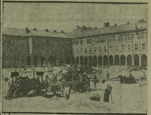
Aszfaltozzák a Templom-teret.
